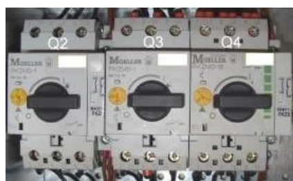
Abb. 4: Motorschutzschalter
