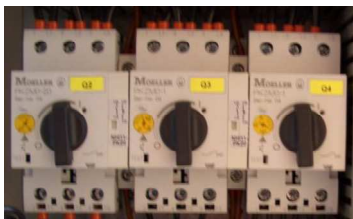
图 1 电机保护开关
